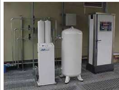
Sistema ozonización automático.
