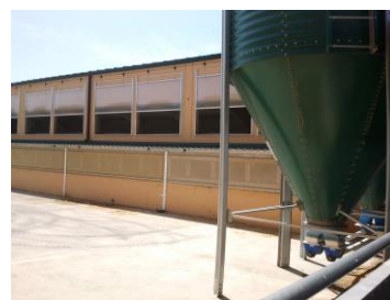
Foto 10P.- Otro sistema de ventilación muy utilizado en cebaderos. Ventanas abatibles automáticas.
