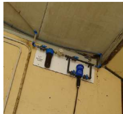
Doble conducción de agua para medicar a voluntad.
