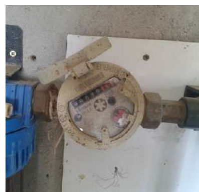
Caudalímetro para medir el consumo de agua.
