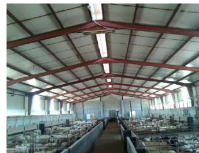
Aislamiento cubierta con placa sándwich. Cumbreira.
