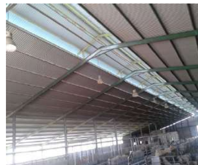
Cubierta no aislada. Posibilidad de goteo en invierno y gran acumulación de calor en verano.
