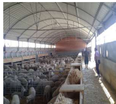
Ventilación con entrada y salidas de aire laterales.
